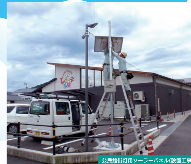
公民館街灯用ソーラーパネル(設置工事)
