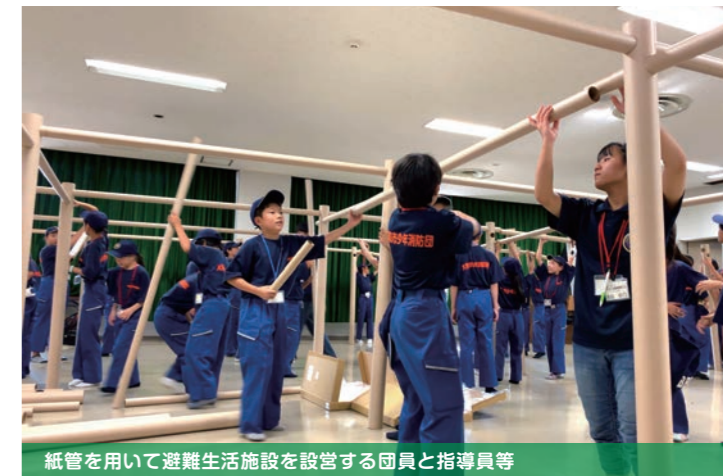
紙管を用いて避難生活施設を設営する団員と指導員等
