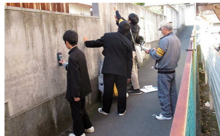
ブロック塀の点検
