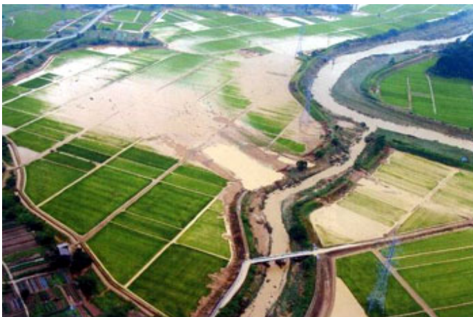
稚児清水川の破堤箇所（14日・石川県消防本部へり撮影）
