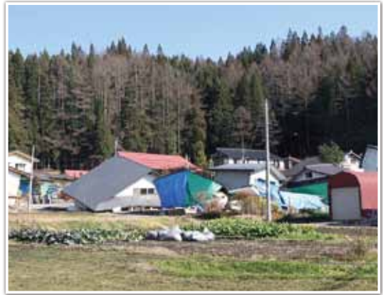
家屋倒壊の状況
