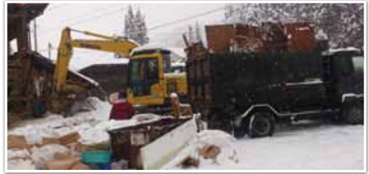
倒壊家屋の解体撤去作業
