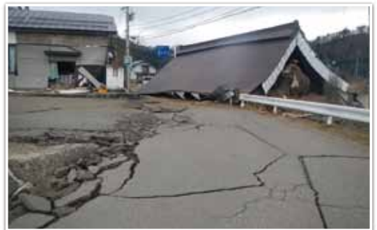
道路の損傷と家屋倒壊
