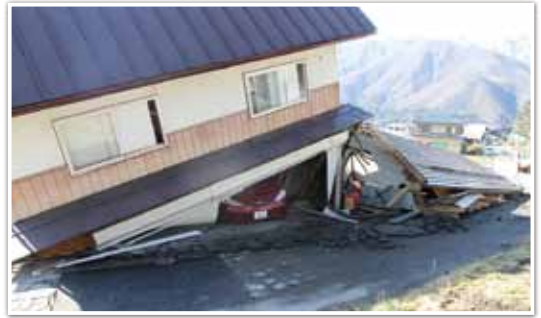
倒壊した家屋の状況
