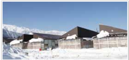
大雪の中で施工された応急仮設住宅
