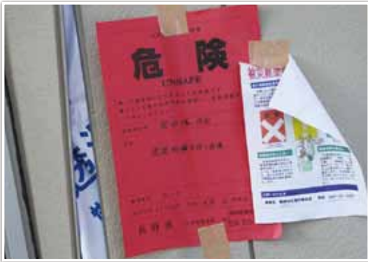
「建築物応急危険度判定」の張り紙
