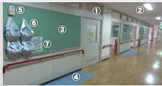
①ガラス飛散防止 ②蛍光管落下防止 ③掲示板固定補強 ④セーフティゾーン ⑤ウエットティッシュ ⑥ヘルメット ⑦避難マニュアル
