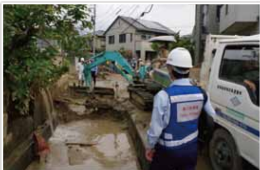
土砂撤去の支援（H26広島土砂災害）
