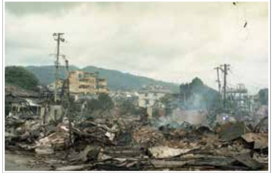
阪神・淡路大震災（兵庫県神戸市灘区）
