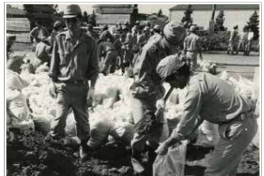
土のうしらえを行う当時の消防団員
