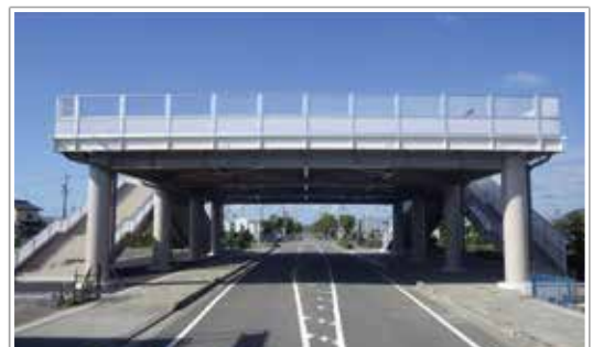
写真-3 津波避難タワー
