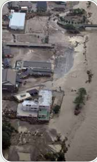
岩手県岩泉町のグループホームの 上空からの被災状況
