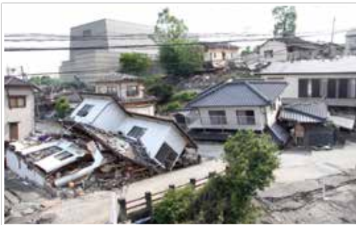
熊本地震による益城町の被害状況
