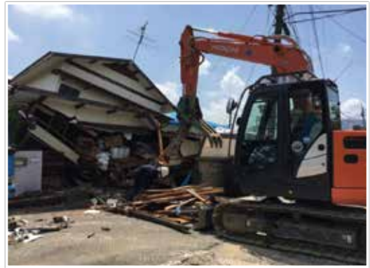
倒壊家屋等の解体撤去
