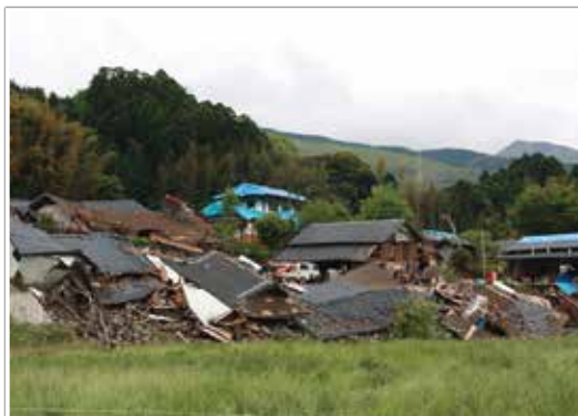
大切畑地区の被災状況
