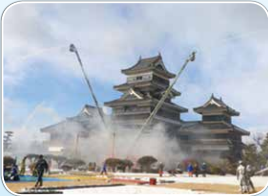
長野県松本市松本城 (1月26日)
