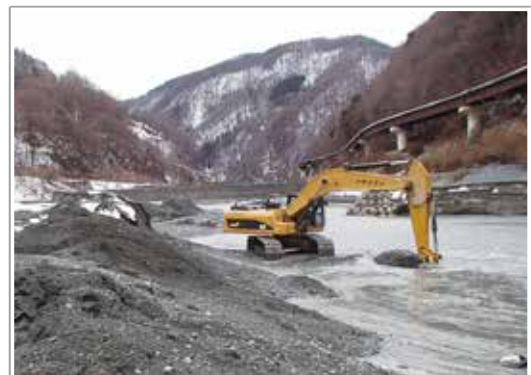
洪水調節容量内の堆砂除去
