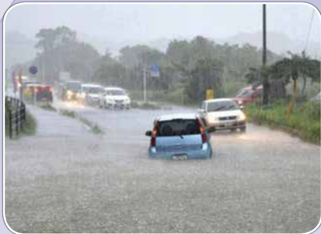
大雨で冠水した屋久島町小瀬田の県道
