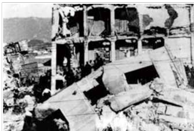
ビルの倒壊、高知市堺町付近 (高知県庁ホームページ)
