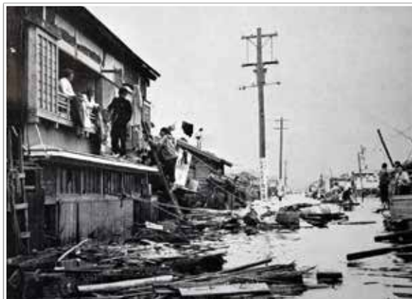
浸水した名古屋市南区の道徳通(『伊勢湾台風災害誌』より)
