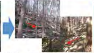
筋工の設置による土壌の保持
