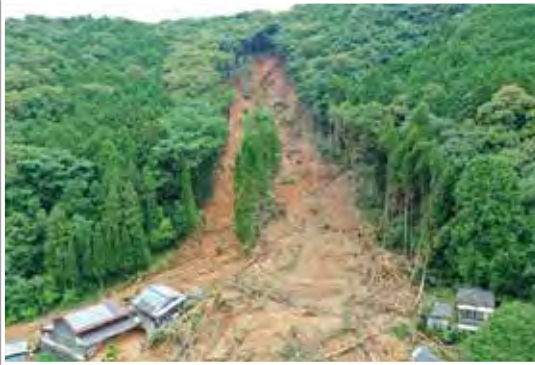
写真4 令和2年7月豪雨で発生した大規模な山腹崩壊(熊本県)
