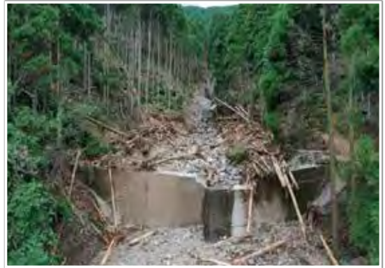
写真3 令和3年7月の大雨で治山ダムが土砂や流木の流出を抑制（鹿児島県）
