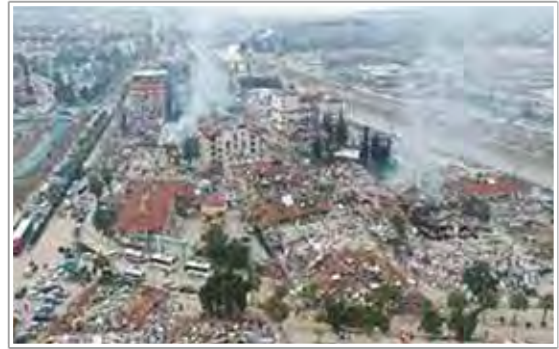
トルコ・シリア地震（トルコの被災状況）
